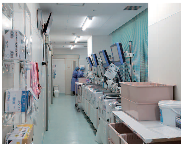
写真-6 内視鏡機器洗浄室
